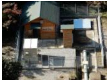
大多喜町 町営 面白峡発電所(小水力)
