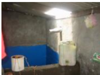
雨水溜め(生活用水・飲料水)
