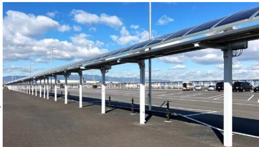
バス停の屋根250mにペロブスカイト太陽電池を設置
